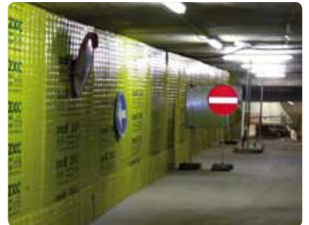
■ Protection et fermeture de site
